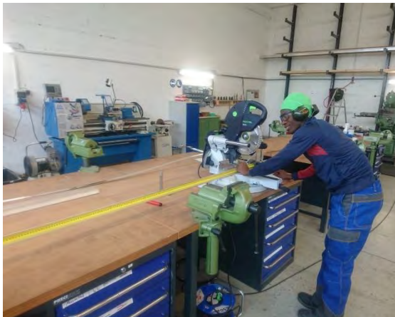
Abbildung 25: Bau der Rahmenkonstruktion des A-Frames
