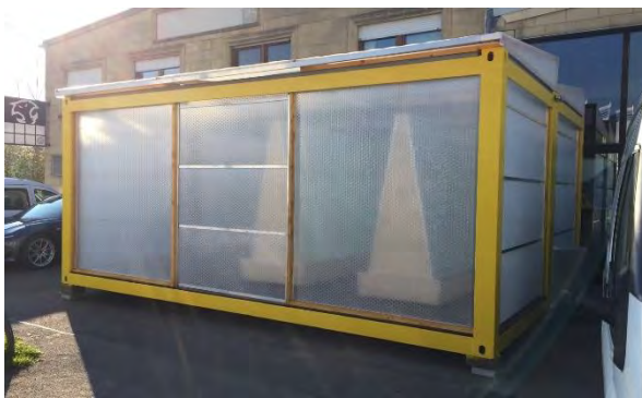
Abbildung 22: Das fertige Gewächshaus mit den beiden in Betrieb genommenen A-Frames
