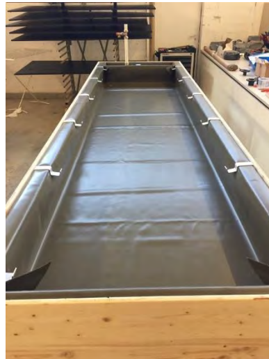
Abbildung 29: Das Becken des A-Frames ist fertiggestellt
