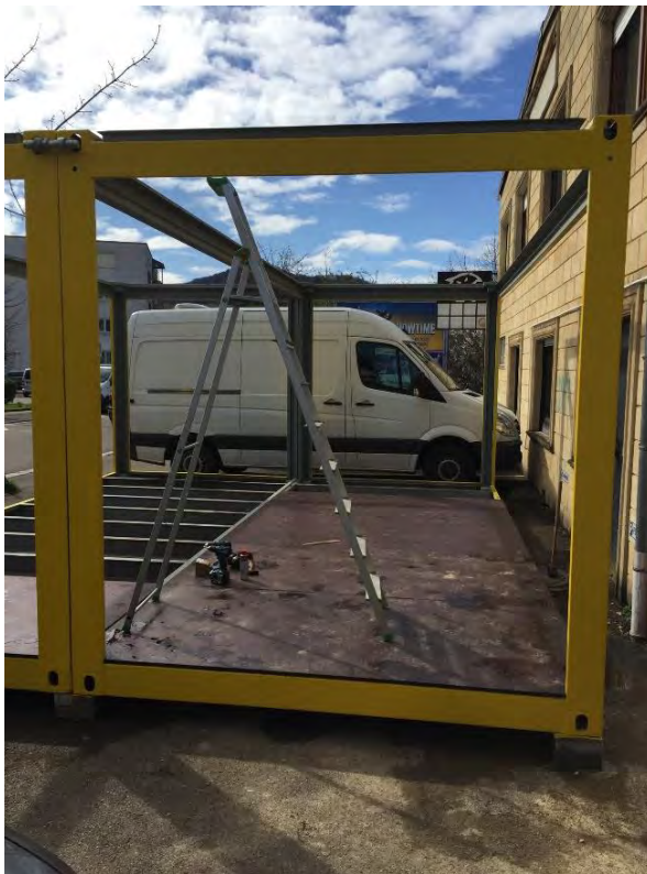
Abbildung 18: Verlegung des Containerbodens
