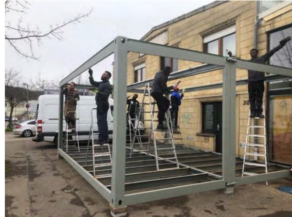
Abbildung 17: Der Containerrahmen wird grundiert
