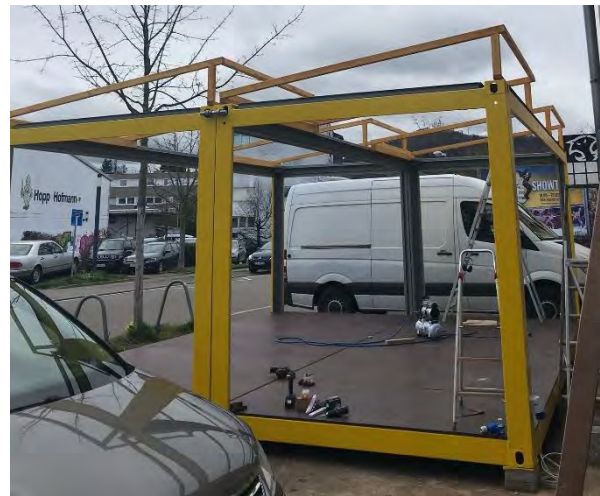
Abbildung 19: Montage der Rahmenkonstruktion des Daches
