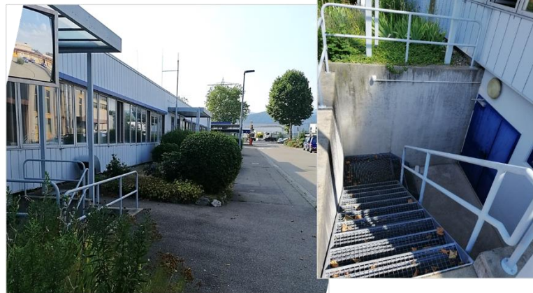
Abbildung 11: Vorgesehener Standort für den Gasdroid am und im Treppenabgang des Betriebsgebäudes "Flunder" der bnNetze GmbH
