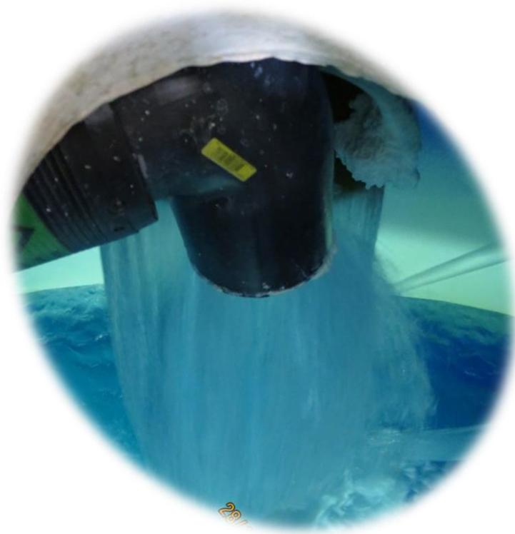
**Bild 8.5:** Calciumcarbonatablagerungen im Zentralsammler an der Behälterwand und am Rohr durch Einmischung von Kalkwasser und Rohwasser
