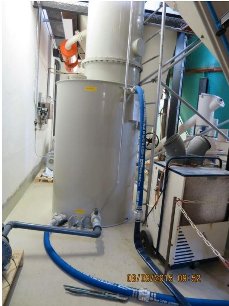
Bild 2.3: Füllkörperkolonne zur mechanischen Entsäuerung
