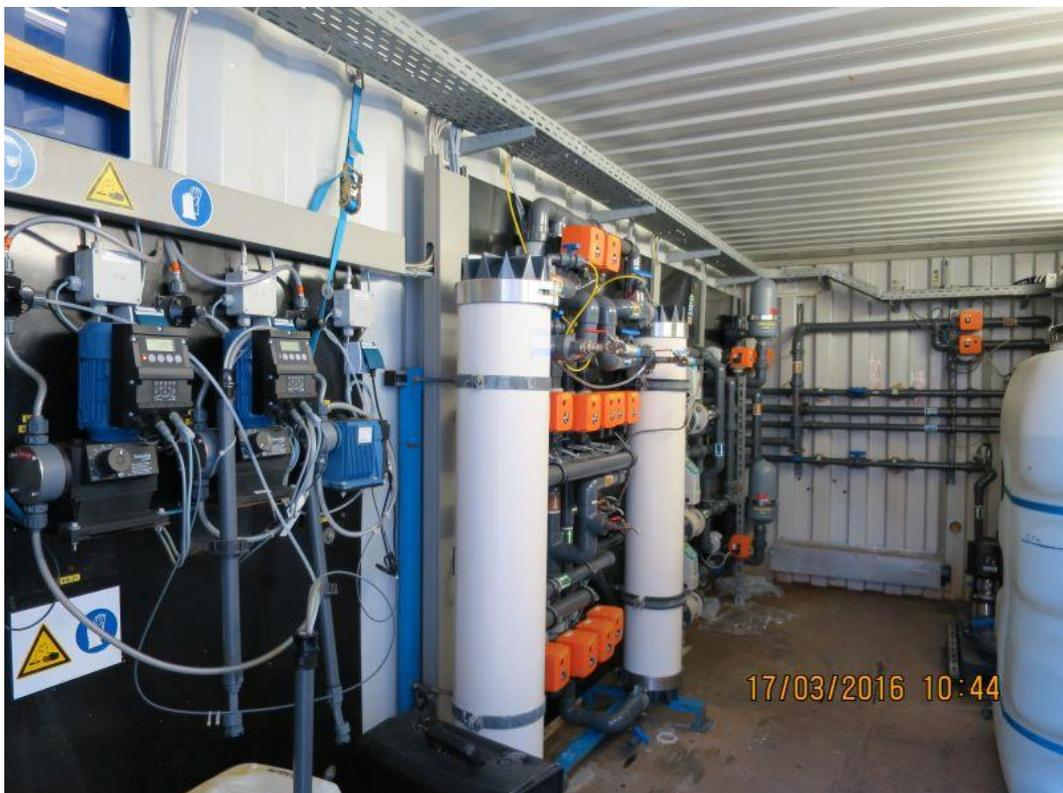
**Bild 2.8:** Ansicht der Versuchsanlage mit Polymermembranen
