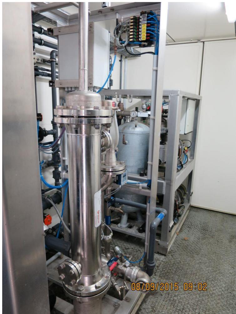
**Bild 2.6: Ansicht der keramischen Membran im Druckrohr, im Hintergrund Spülwasserbehälter und Kompressoren**
