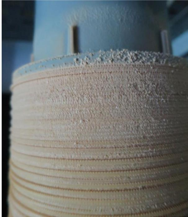
**Bild 6.2: Calciumcarbonat-Ablagerungen im oberen Teil des Vorfilters nach einer Behandlung von 5.000 m<sup>3</sup> Kalkwasser**
