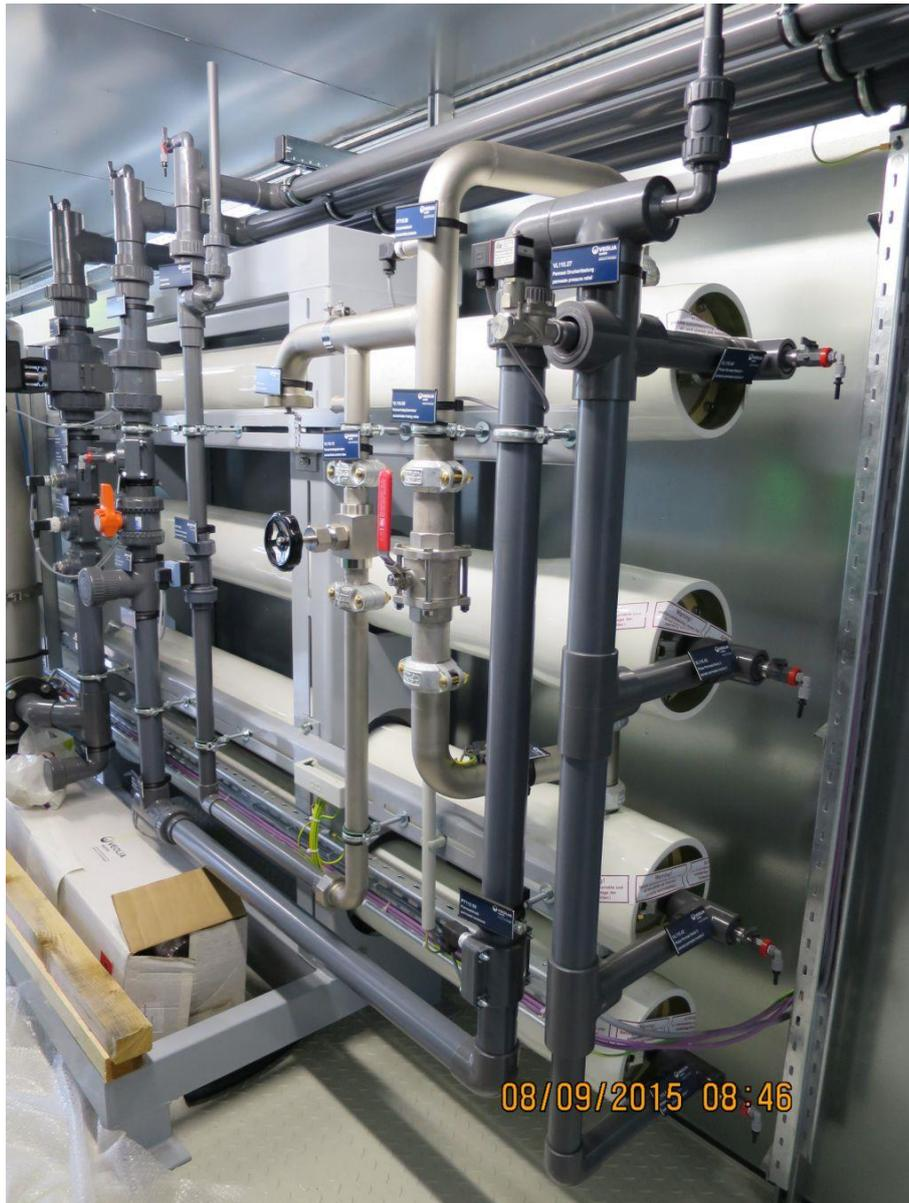
Bild 2.2: Ansicht der Umkehrosmoseanlage, mittig manuell zu bedienendes Konzentratregelventil
