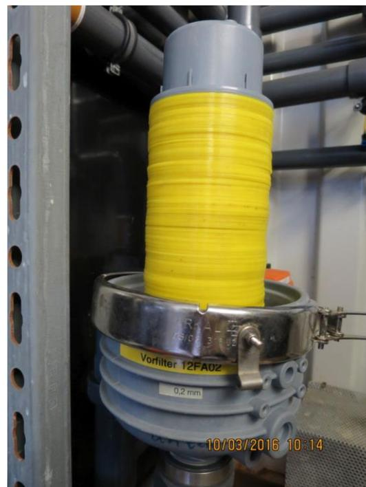
Bild 2.7:  $200\ \mu\text{m}$  Vorfilter für die Polymermembranen
