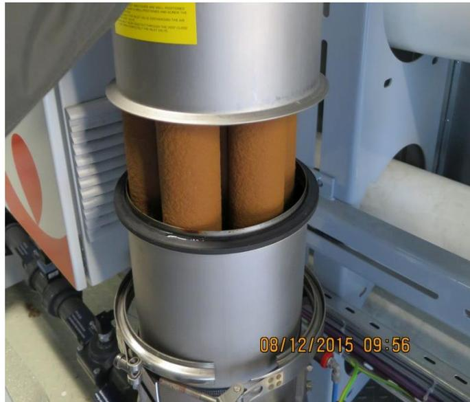
**Bild 4.1: Mit Eisenoxiden belegte Vorfilter der Umkehrosmose nach ca. 80 Tagen Betriebszeit**
