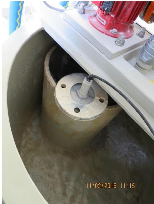
**Bild 5.15: Calciumcarbonatablagerungen im Ansatz- und Kontaktbehälter**
