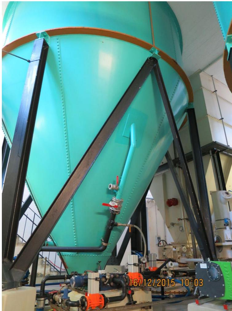
**Bild 1.1: Kalkwassersättiger (links) und Kalksilo (rechts) im Wasserwerk Ebneth**
