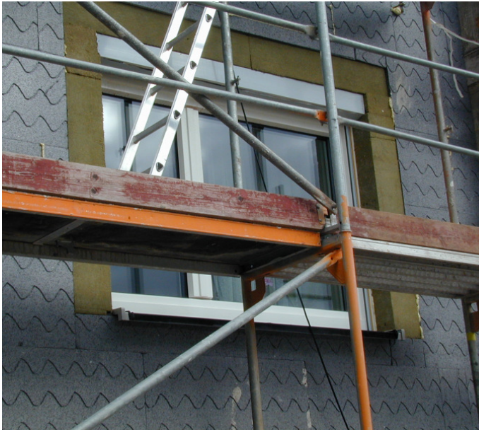
Brandbarriere aus Mineralwolle b = 30\text{ cm}
