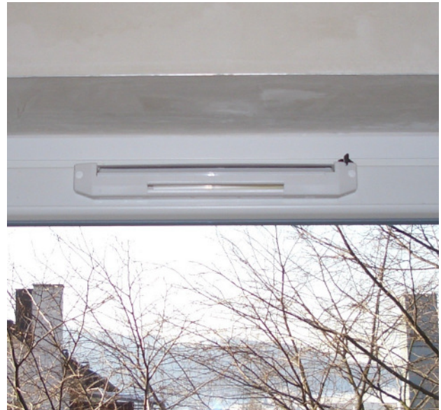
Mechanisch hygrometrisch reguliertes Zuluftventil im Fensterflügel in Wohn- und Schlafräumen, 17,5 bzw. 20 m 3 /h pro Element / Raum
