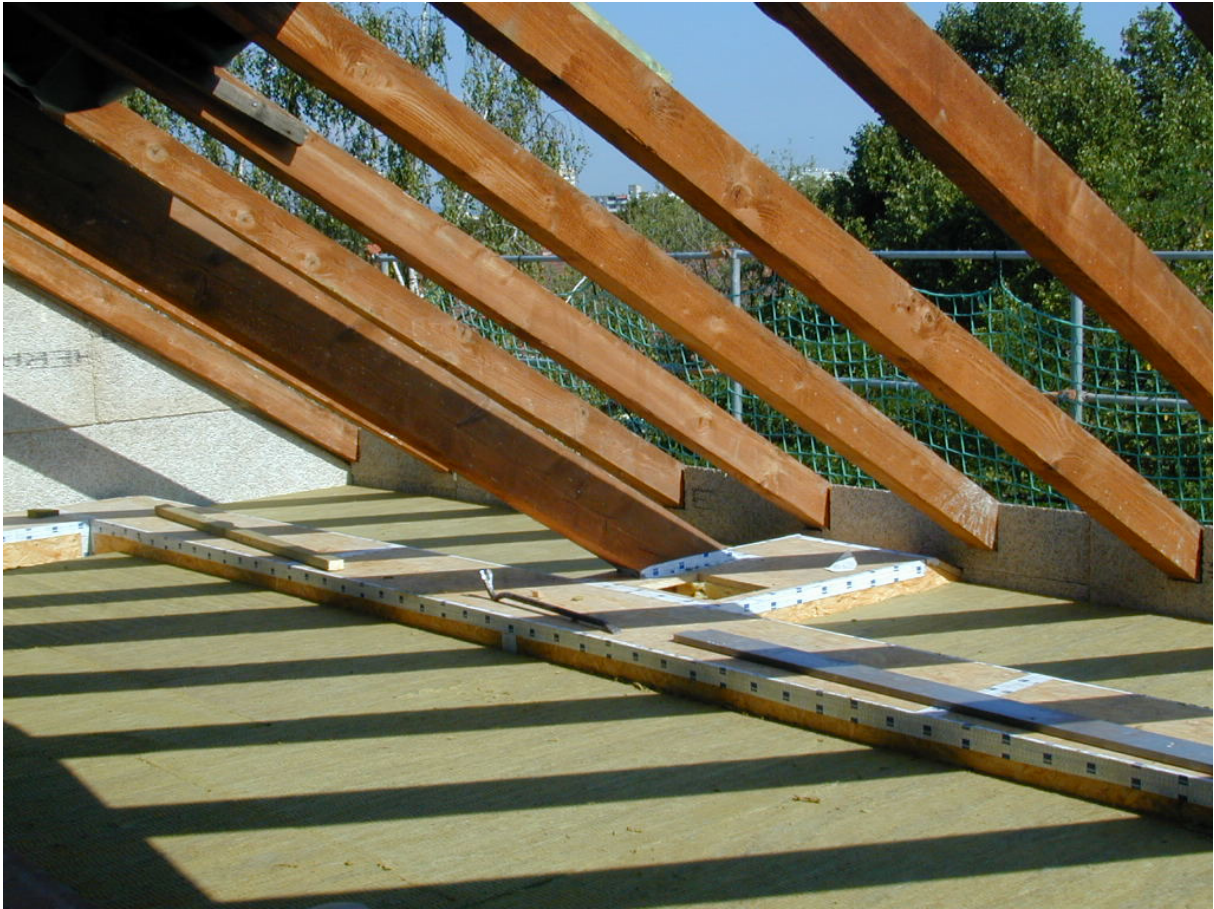
Dachboden nach der Sanierung mit begehbare Mineralfaser-Dämmung und Installationskasten
