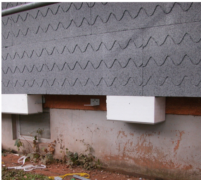
Sockelanschlusselement anstatt Abschlusswinkel
