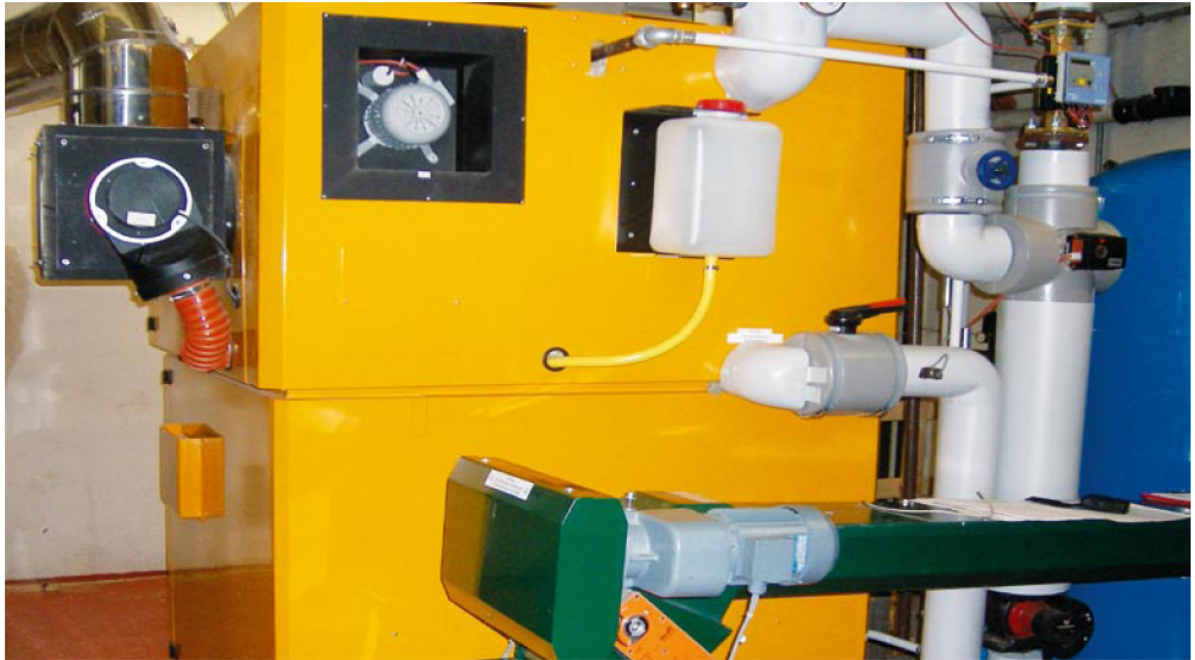
Neuer Heizkessel in der Hellbergschule, Lörrach
