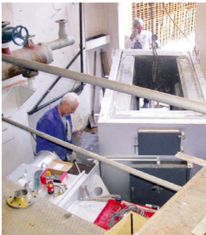
Einbau der Heizanlage im Kant-Gymnasium, Weil am Rhein
