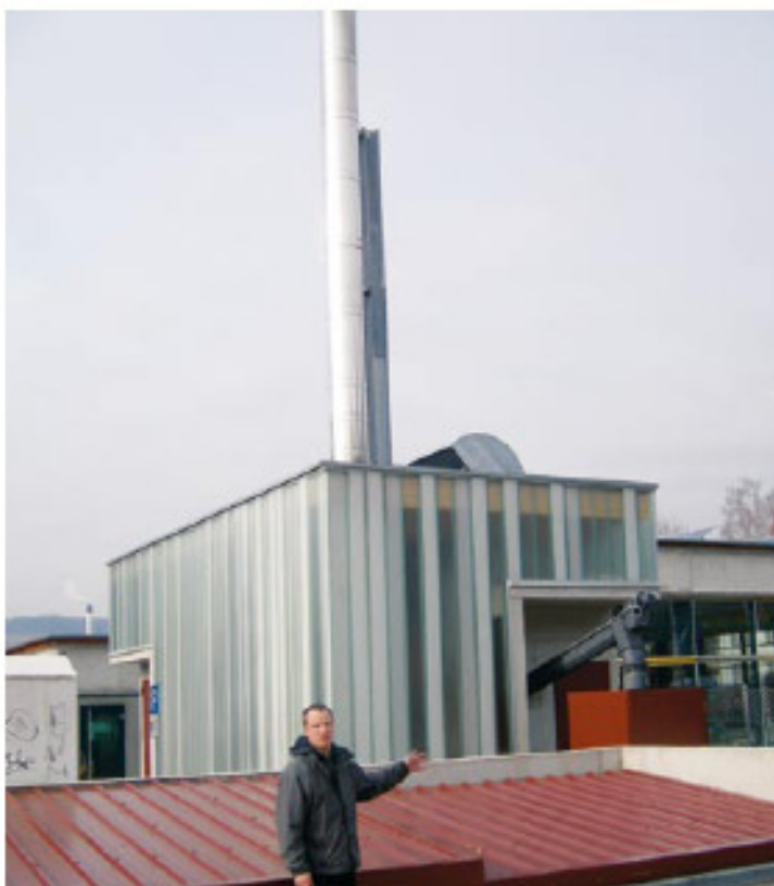
Die neue Holzhackschnitzelanlage am Hallenbad Lössach
