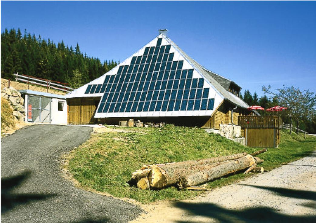
Abb. 5: Der Rappenecker Hof mit dem Solargenerator. Links daneben der Gasbereitstellungsraum für die Energieversorgung der Brennstoffzelle.
