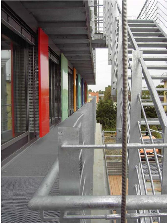
Abbildung 5: Vergitterungen hinter den Verblendungen und Fluchtbalkone
