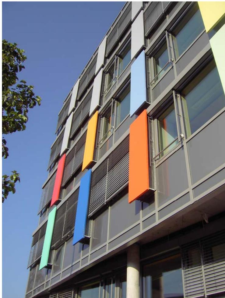
Abbildung 4: Farbige Verblendungen der Lüftungsklappen an der Fassade
