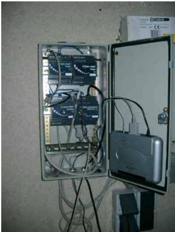
**Bild 1: VEC Databox mit Datenlogger, Pulsumsetzer, Analogumsetzer und Modem**
