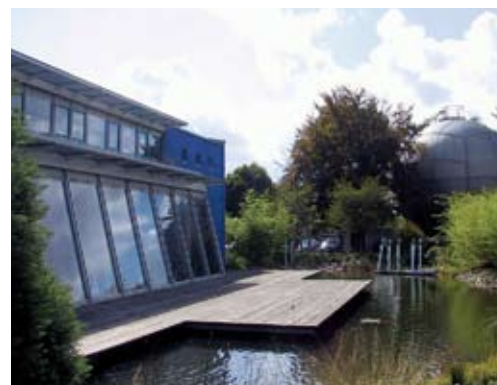
Ökologische Gebäudefassade in Lörrach.
