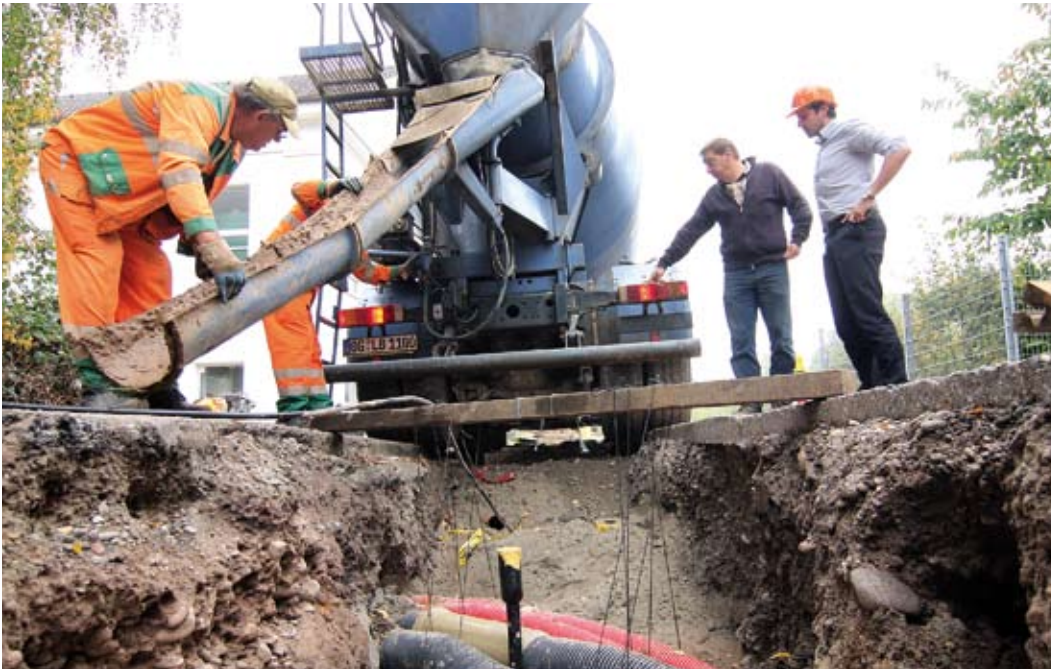
Einsatz des umweltschonenden Flüssigbodenverfahrens beim Rohrleitungsbau.
