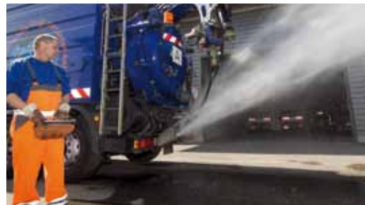
Kanalspülung durch bnNETZE.
