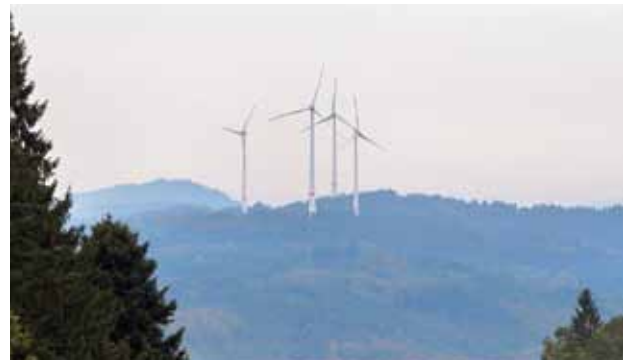
Seit dem 14. Oktober 2016 ist der Windpark Kambacher Eck am badenova Netz. Fast 10.000 Haushalte werden so mit grünem Strom versorgt.
