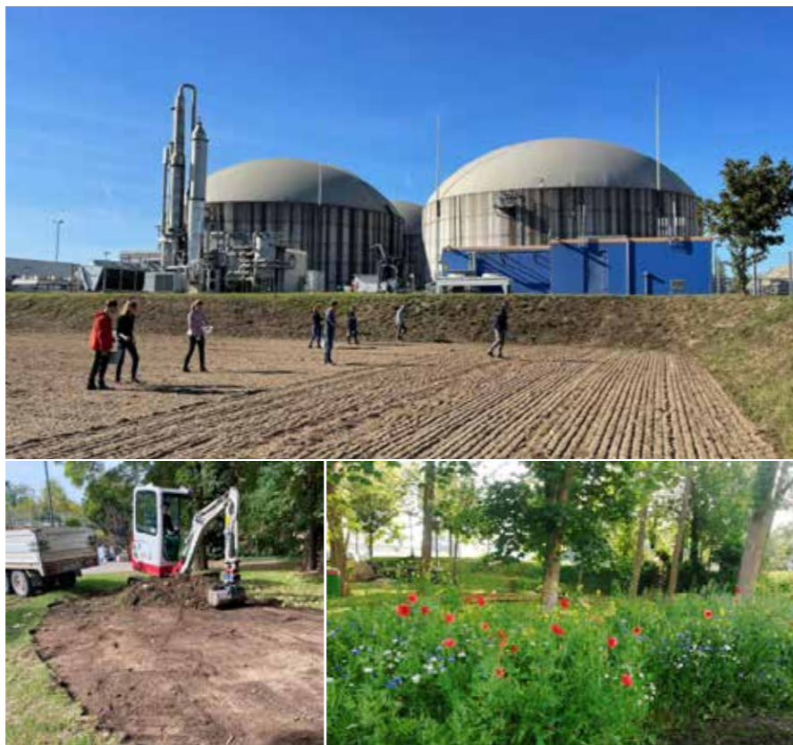
Aussaat einer Wildblumenmischung an der Biogasanlage in Eschbach (oben)
