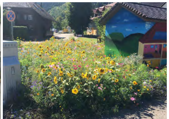
Trafohaus Oberried nach der Umgestaltung
