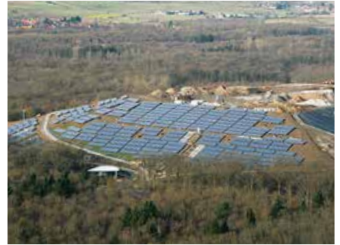
Das Freiland-Solarpark auf der ehemaligen Mülldeponie Eichelbuck ist das solare „Leuchtturmprojekt“ Freiburgs. Die 2,5 Fußballfelder große Anlage ist ein Gemeinschaftsprojekt von badenova und der Abfallwirtschaft und Stadtreinigung Freiburg (ASF) und produzierte im Jahr 2018 rund 2.764.480 Kilowattstunden Strom für circa 1.100 Haushalte.
