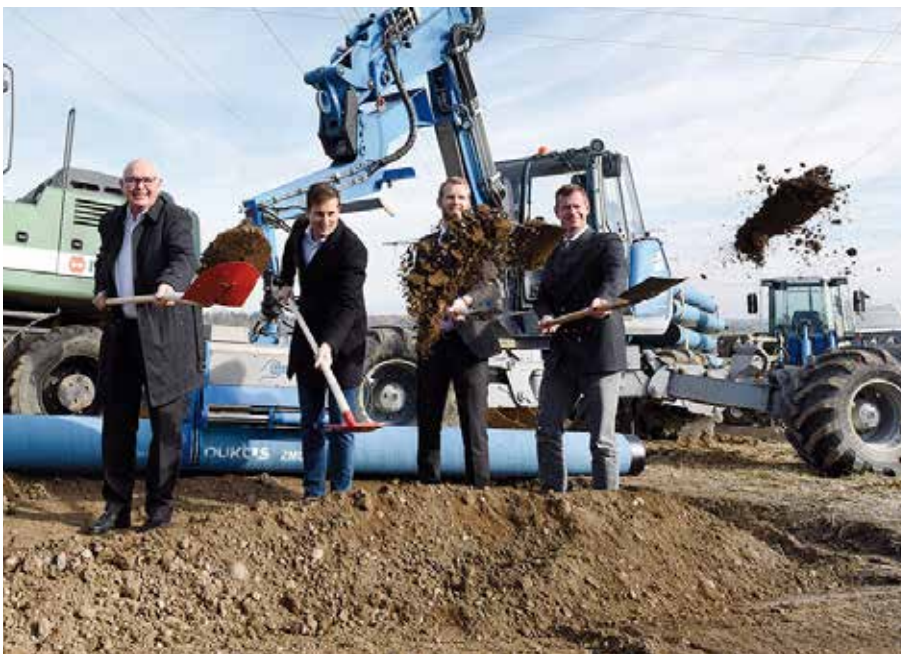
badenova Vorstand Mathias Nikolay sowie die Bürgermeister Martin Rupp (Merdingen), Benedikt Eckerle (Ihringen) und Oliver Rein (Breisach) beim Spatenstich am 9. November 2018.
