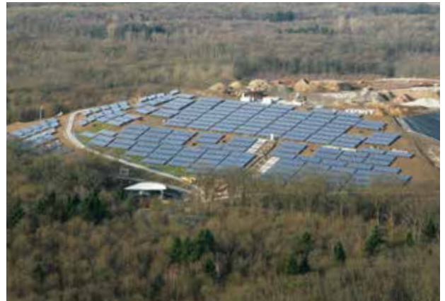
Das Freiland-Solkraftwerk auf der ehemaligen Mülldeponie Eichelbuck ist das solare „Leuchtturmprojekt“ Freiburgs. Die 2,5 Fußballfelder große Anlage ist ein Gemeinschaftsprojekt von badenova und der Abfallwirtschaft und Stadtreinigung Freiburg (ASF) und produzierte im Jahr 2017 rund 2.763.760 kWh Strom für circa 1.100 Haushalte.
