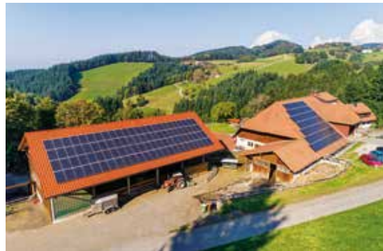
Der „Sonnen Kombi“-Kunde Ringlihof in Horben mit 53-kWp-Solaranlage und 24-kWh-Stromspeicher
